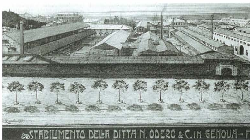
Lo stabilimento della ditta Otero alla Foce.
